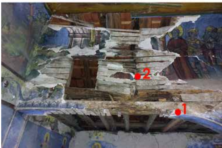
Сл. 14 - Локација на примероците: а) - од сводните фрески на плацки од катната галерија и од страничниот северен ѕид во катната галерија од црквата Св. Димитрија, с. Драчевица (означени како примерок бр. 1 и 2; б) - примерок бр.1 (фотографии од А.Поповска. А.Рибарска –ИКОМОС МК)
