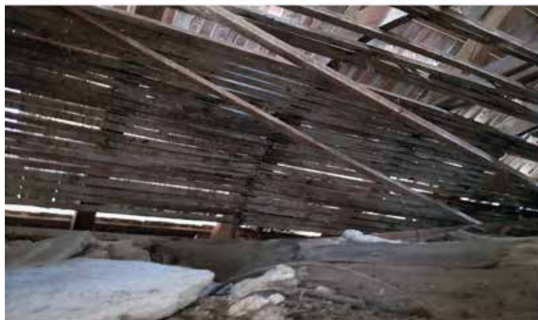
Сл. 3 – Детали од црквата Св. Димитрија, с. Балинци: Рамна таваница како „лажна“ сводна, над која е подконструкцијата изведена од тенки дрвени летви споени со полукружни напречни лачни греди (фотографии од А.Поповска-ИКОМОС Мк)
