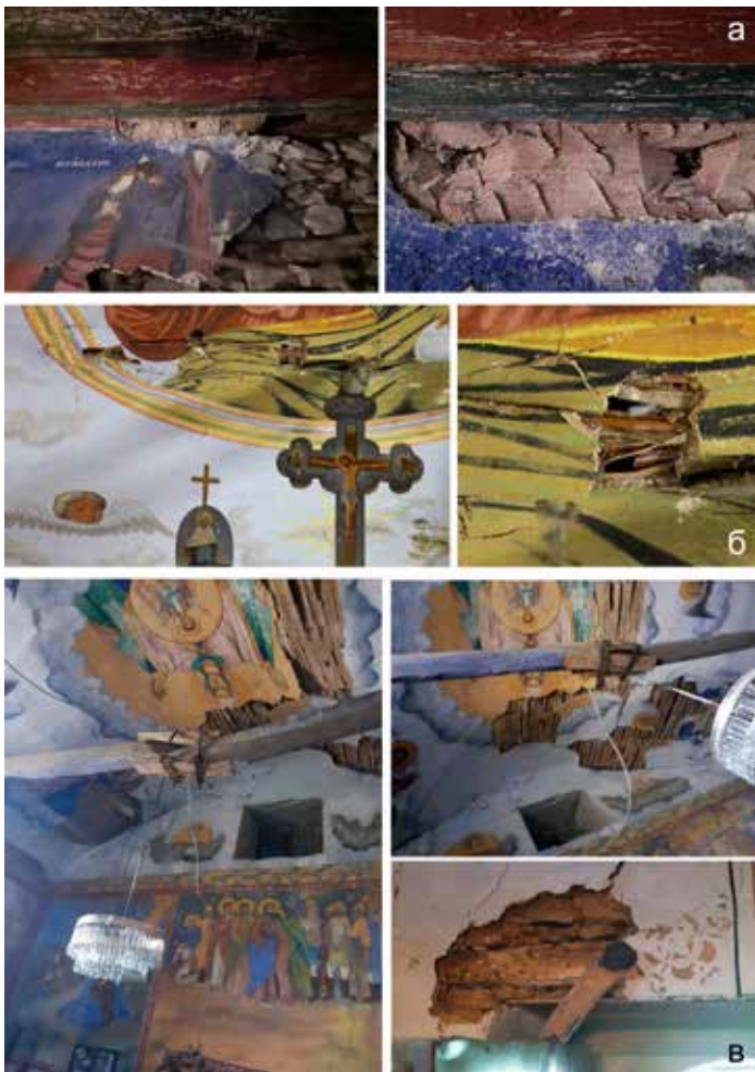
Сл. 10 - (а) - Дрвена рамка како контакт помеѓу декоративната таванска конструкција и периметралните сидови од камен во Св. Димитрија с. Драчевица; (б) - Сводни фрески на плет од прачки во Св. Троица, с. Раштани и (в) - Сводни фрески изведувани на систем од дрвени итици во Св. Илија, с. Долно Врановци –Чашка (фотографии од А.Поповска. И.Коцевска-ИКОМОС Мк)
