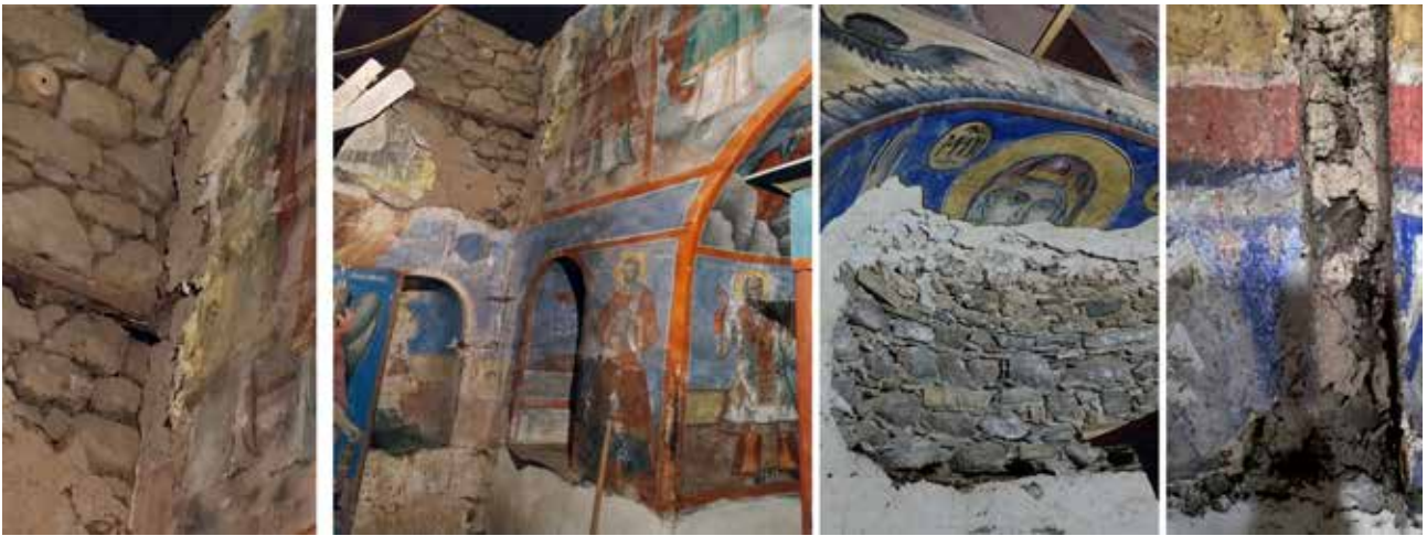
Сл. 6 - Изведување на фреско врз периметрални ѕидови со нанесување на малтер на камена подлога во преродбенски цркви (фотографии од А.Поповска-ИКОМОС Мк)
