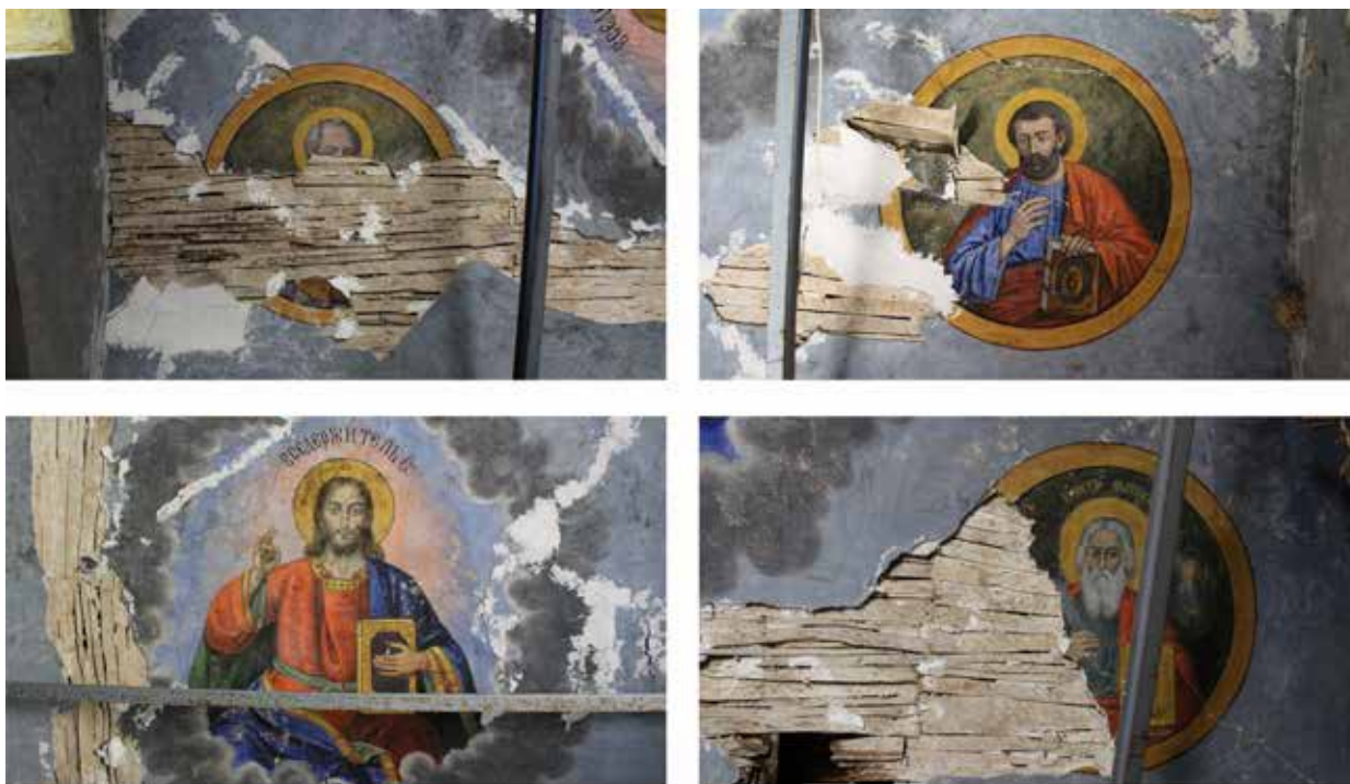
Сл. 15 - Детали од отпаднати регии на сводни фрески изведени на систем од дрвена конструкција во црквата Св. Троица, с. Брезница
